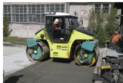
Rys. 4. Cykliczne zagęszczanie warstwy z betonu wałowanego [9]
