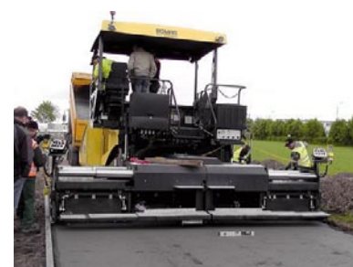
Rys. 3. Wbudowanie warstwy RCC za pomocy rozścielacza do asfaltu [9]
